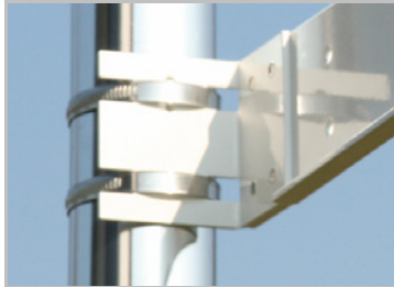
Abb. 8: Montage an einem Mast mit Schneckengewinde-Schellen
