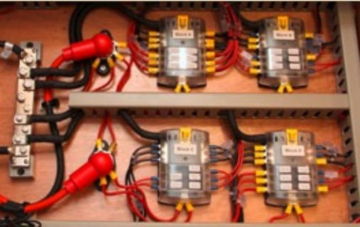
Auf der Yacht KONNEXA wurden ca. 100m KNX® Busleitung, 800m Aderleitungen, 350m hochflexible spezielle 230V Leitungen, 350m Netzwerk- und Multimedialeitungen sowie 200m sonstige Kabel- und Leitungen verlegt. Es wurden in 5 Elektroverteilungen und 6 Räumen insgesamt 91 KNX® Geräte verschiedenster Hersteller als Reiheneinbau (REG) sowie Unterputz (UP) und Aufputz (AP) installiert, welche über ca. 1.800 Gruppenadressen im Bussystem kommunizieren (inkl. NMEA).
