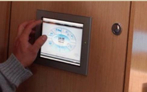
Präsenzmelder übernehmen Mehrfachfunktionen, von der Beleuchtungssteuerung über den Tag-/Nachtbetrieb in verschiedenen Lichtszenen bis hin zum Alarmanlagenbetrieb. Internet, Multimedia sowie Stör-, Betriebs- und Statusmeldungen sind ebenso selbstverständlich wie eine automatische Rauchmelde- und Bilgenüberwachung mit besonderen KNX® fähigen Wassersensoren.
