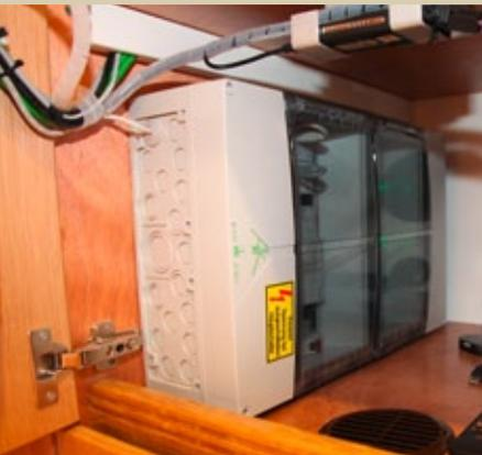
Belüftete, gummierte KNX® Schnittstellenverteilung
